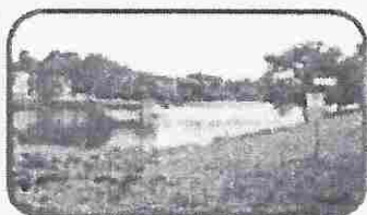
la retenue d'eau superficielle des Martinats
